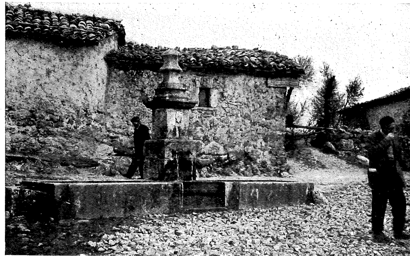
Fot. 25.—Fuente pública en la carretera, entrada a Salinas de Rosío.
